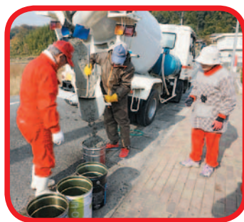
作業場の基礎づくり
